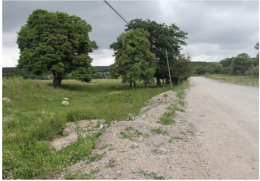
Fotoğraf 67: Arslantaş Yolu, Yol Yapım ve Genişletme Çalışmaları
